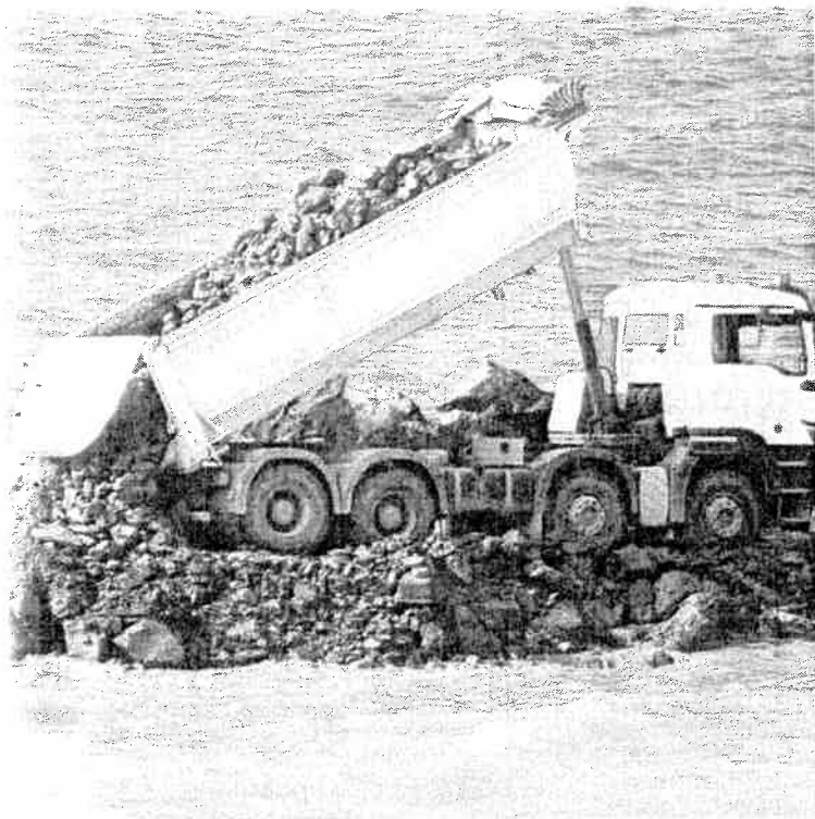
Un camion delle ditte del movimento terra al lavoro nel porto
